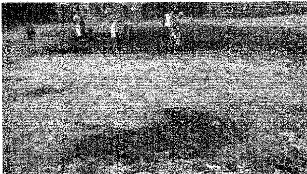
Figura 2.1 - Rimozione coltre erosa
